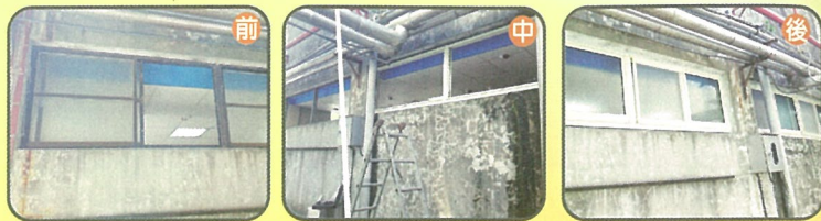
C棟1F廁所新面貌
