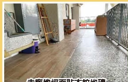
走廊地坪面貼木紋地磚
