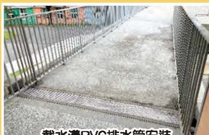
截水溝PVC排水管安裝
